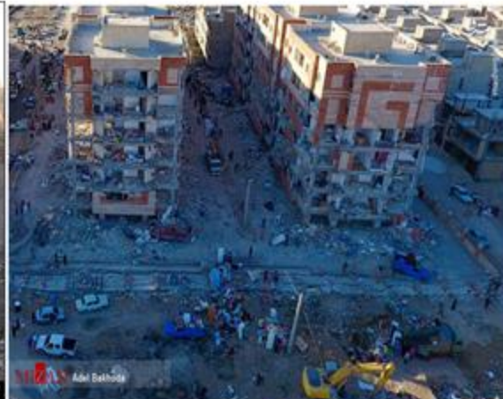
زلزله سربل، زهاب
